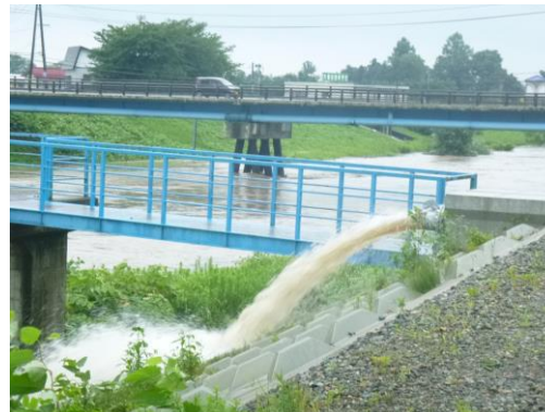
大曲地域 大花町 排水状況
